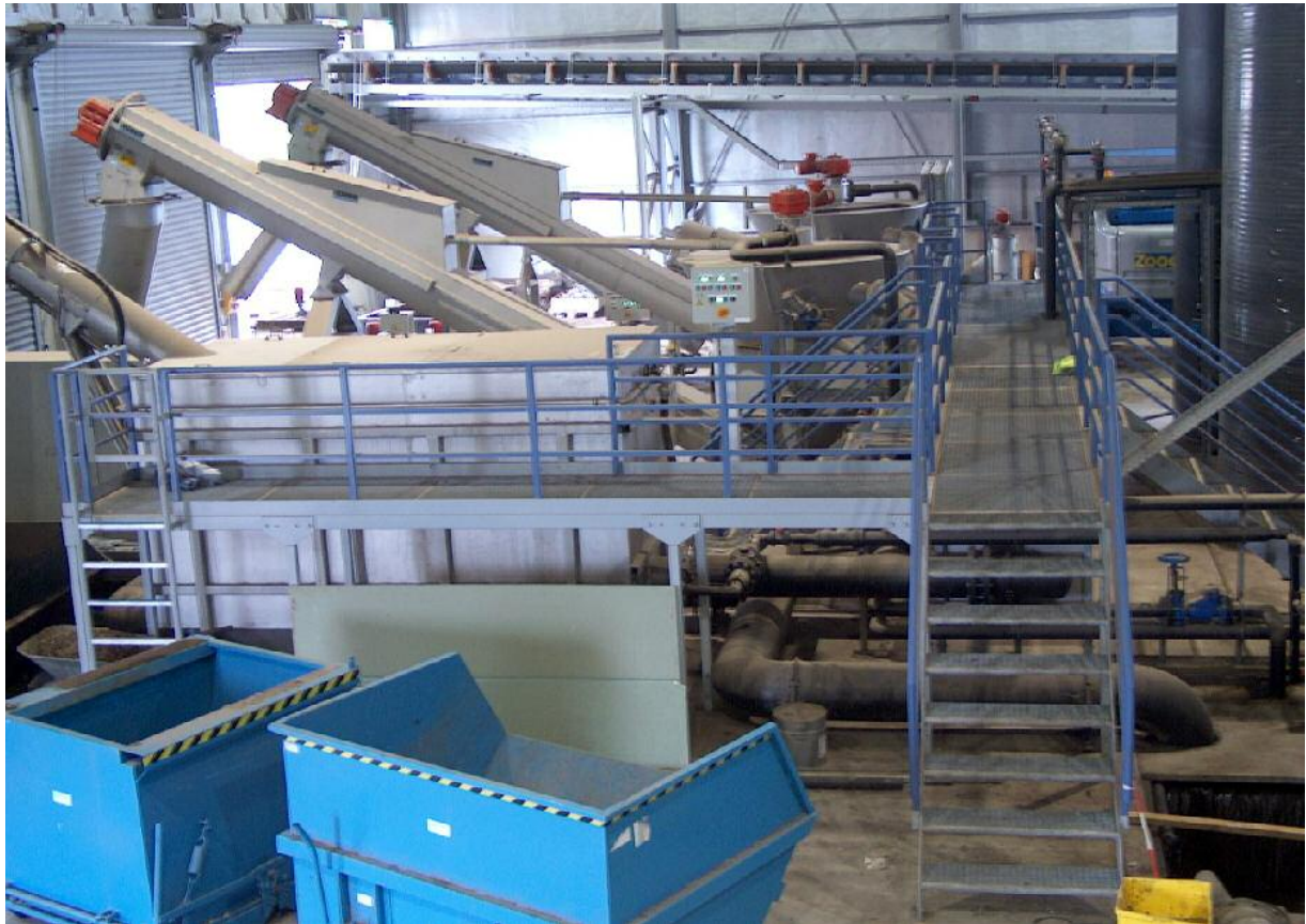
Abbildung 3 Sandwäscher und Siebanlage / gritwasher and screening
